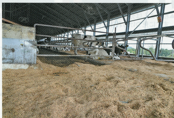
▲通路にはゴムマットを敷き、粃殻を敷いて段差を埋めている
